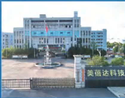
企业科技大楼、正大门
